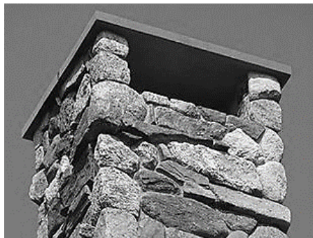
Stone Cap Chimney Top
